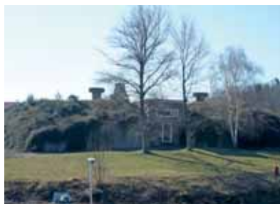
Le réservoir des Chaumières (impasse du Matharet).
