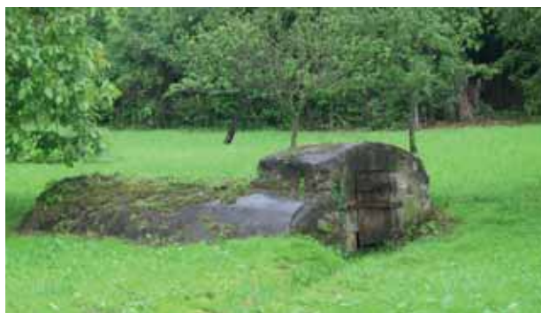
Citerne de captage de la source de La Cheyre (à l'ouest du stade de l'Artière).
