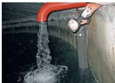
Intérieur d'une cuve.
