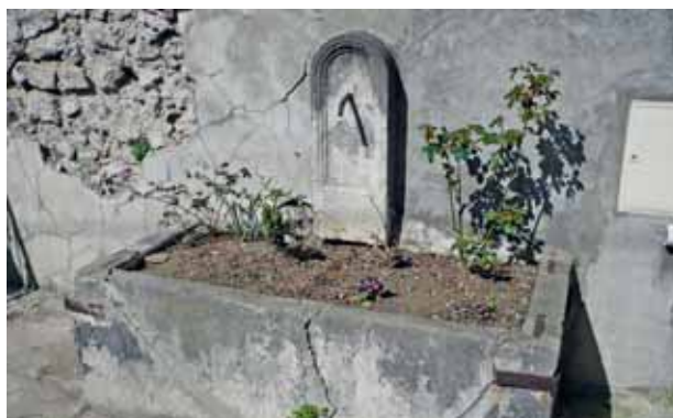
La fontaine des Chauffours (rue Victor-Hugo).
