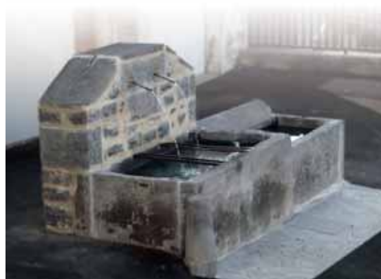
Les fontaines du Terrail (ci-dessous) et de la Halle (ci-contre) après leur remise en eau (printemps 2009).
