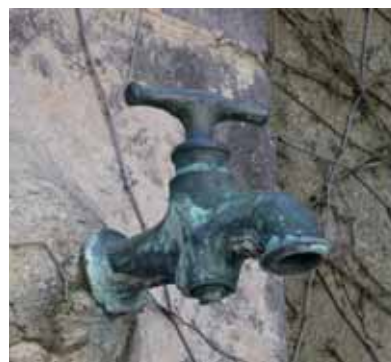
Robinet de la fontaine du clos Soubrany (de type « à boisseau »).
