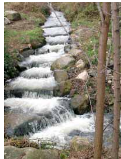
Échelle à poissons du grand bassin d'orage.
