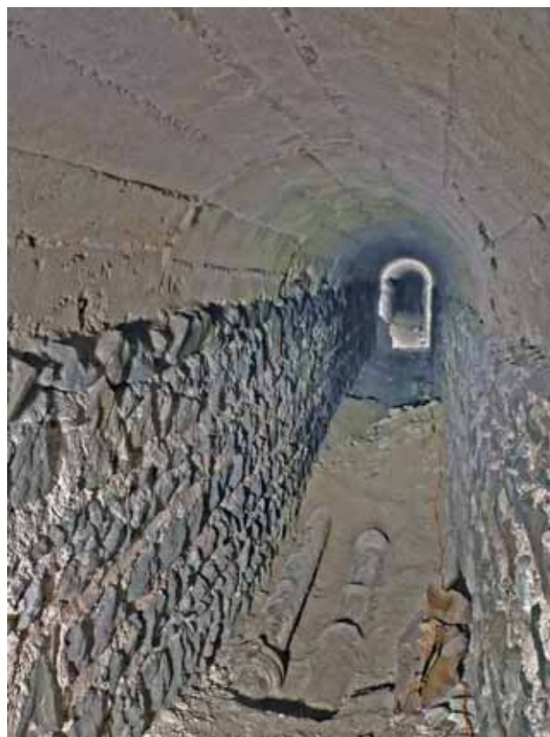
Galerie de l'adduction d'eau, avenue du Stade. Construite en 1842, elle abrite toujours une section de la nouvelle canalisation en terre cuite posée cette année-là, et des tuyaux en fonte installés en 1913 (respectivement au centre et à gauche de la galerie sur cette photographie). Sur la conduite en terre cuite est visible une réparation en tuyaux de plomb.
