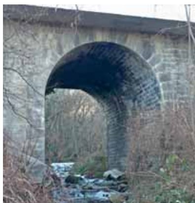
Pont de la route nationale 89 (avenue du Mont-Dore), 1847 ; tablier élargi en 1968.
