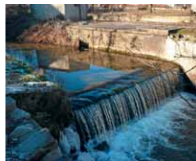
Rue de Pourliat, barrage et cuve enterrée.
