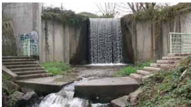
Ouvrage de tête du grand bassin d'orage.
