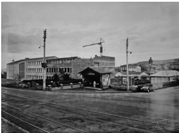
La deuxième tranche de l'école Jean-Zay en construction, avec l'emplacement encore vide de la sculpture de Raymond Coulon (vers 1961). Le monument aux Martyrs de la Résistance se trouve sur son emplacement d'origine. Phot. Léon Gendre, Arch. mun. Beaumont.
