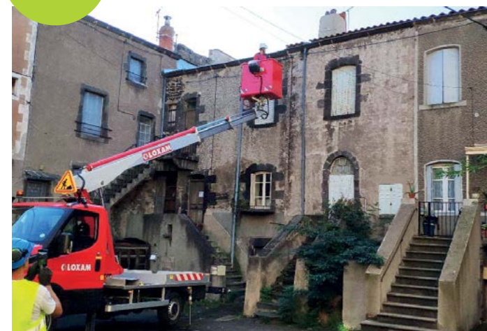
13 Obturation d'ouvertures dans des bâtiments communaux afin de limiter la présence des pigeons dans le bourg
