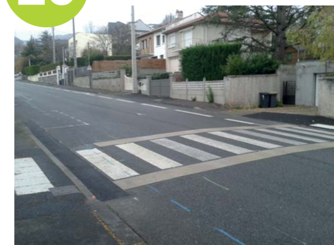
20 Mise aux normes d'accessibilité de passages piétons
