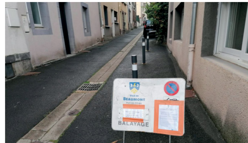
Réfection dans la cour de l'élémentaire Jean Zay
