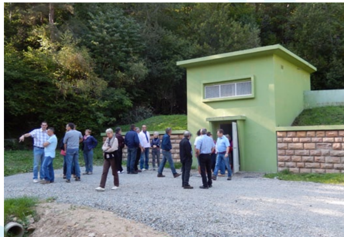
Fin septembre 2014, une visite des installations du SIAP a été organisée à l'attention des élus.
